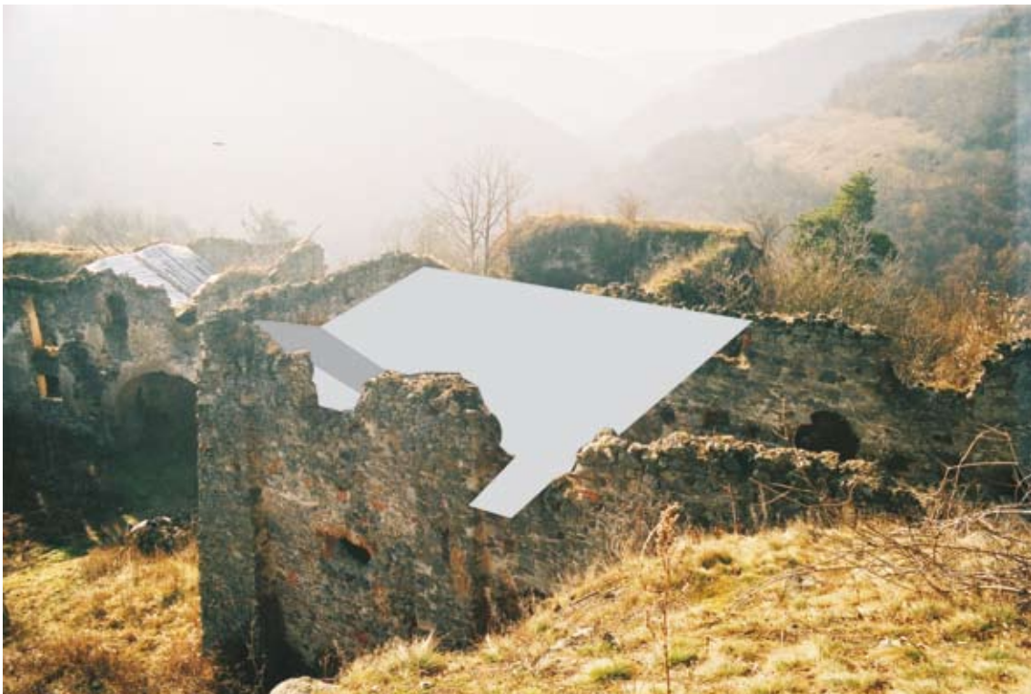
Objekt sýpky pri pohľade zo skalného masívu pod horným hradom s vyznačením základného tvaru plánovanej pultovej strechy
