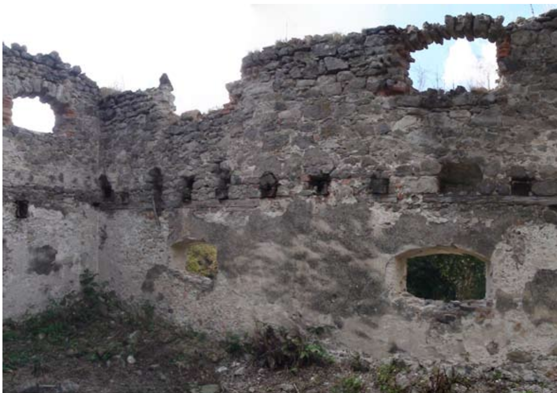
Detailný pohľad na západnú stenu sýpky v interiéri.
