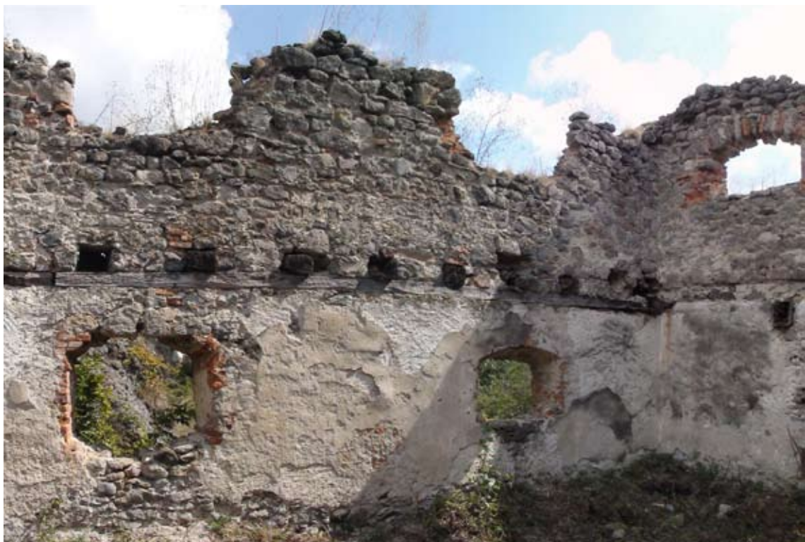
Detailný záber na východnú stenu v interiéri sýpky v mieste, kde je zámer umiestniť skrytú striešku - cez ľavé okno by bol vyvedený chrlič mimo objekt.
