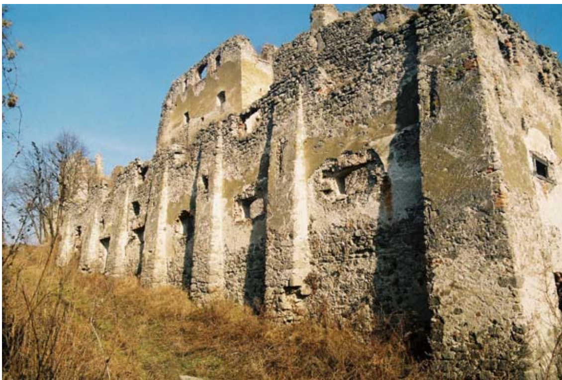
Západná fasáda budovy sýpky je členená opornými piliermi do pravidelných polí
