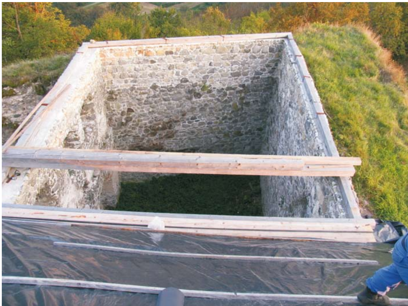
Pohľad do interiéru prístavby 2. vstupnej brány
