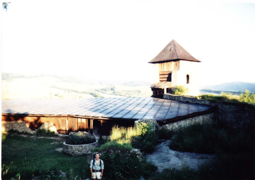
Hrad Brumov - zastrešenie paláca
