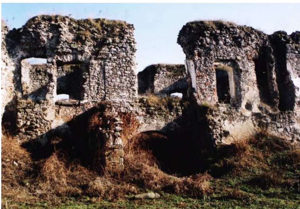
III. vstupná brána – exteriér západného portálu
