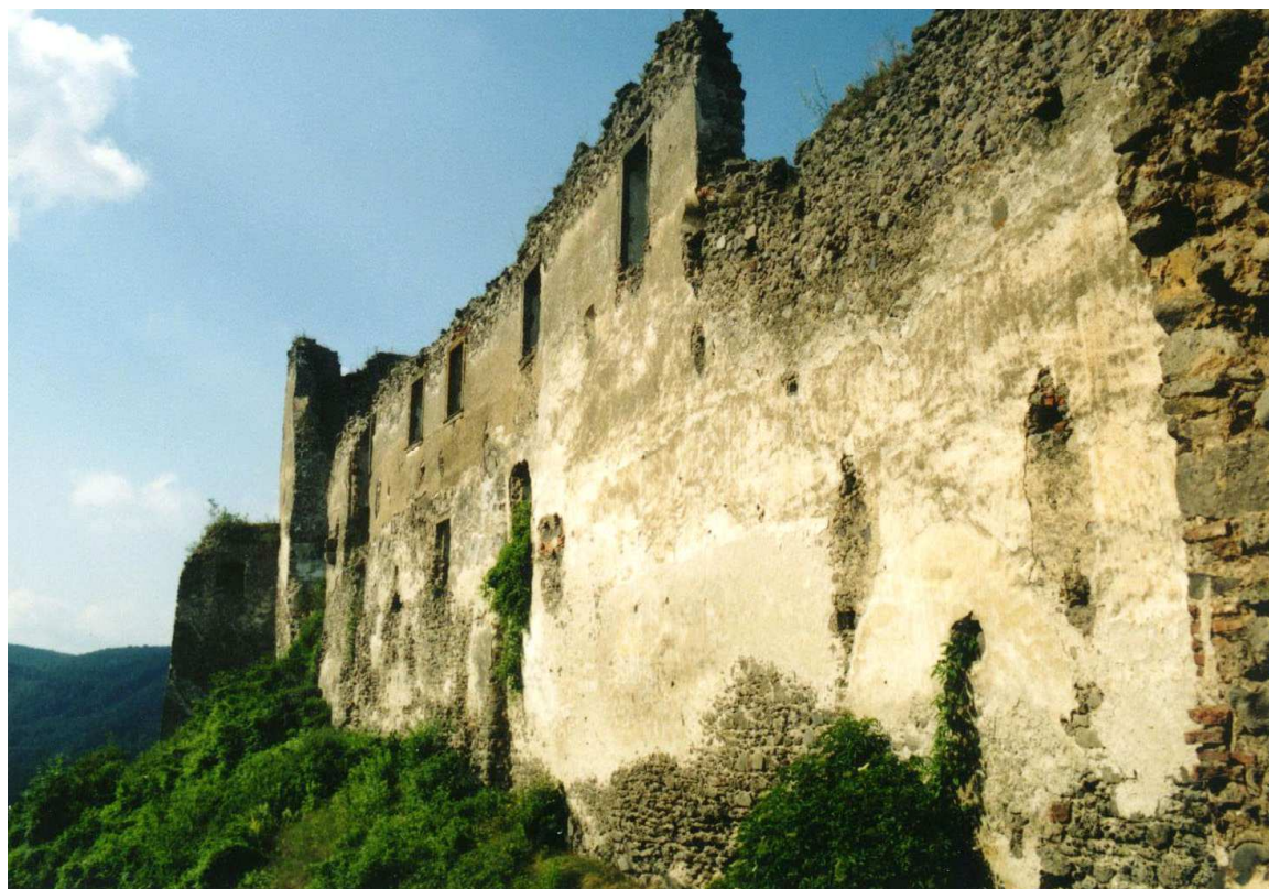
Pohľad na exteriér steny východného paláca
