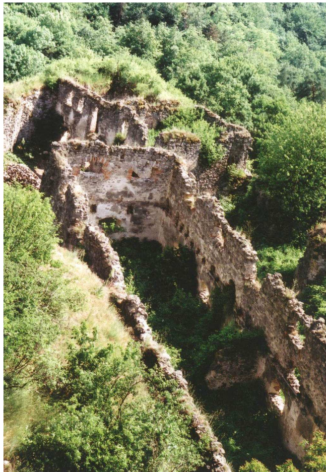
Budova sýpky - pohľad do interiéru
