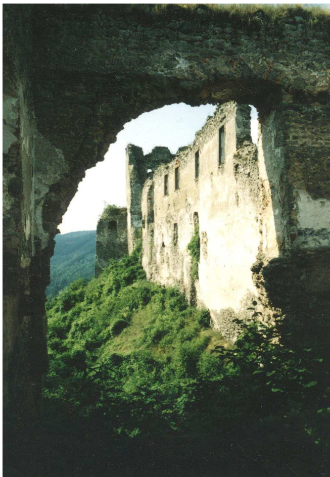
III. vstupná brána – pohľad na deštruovaný južný portál z interiéru.
