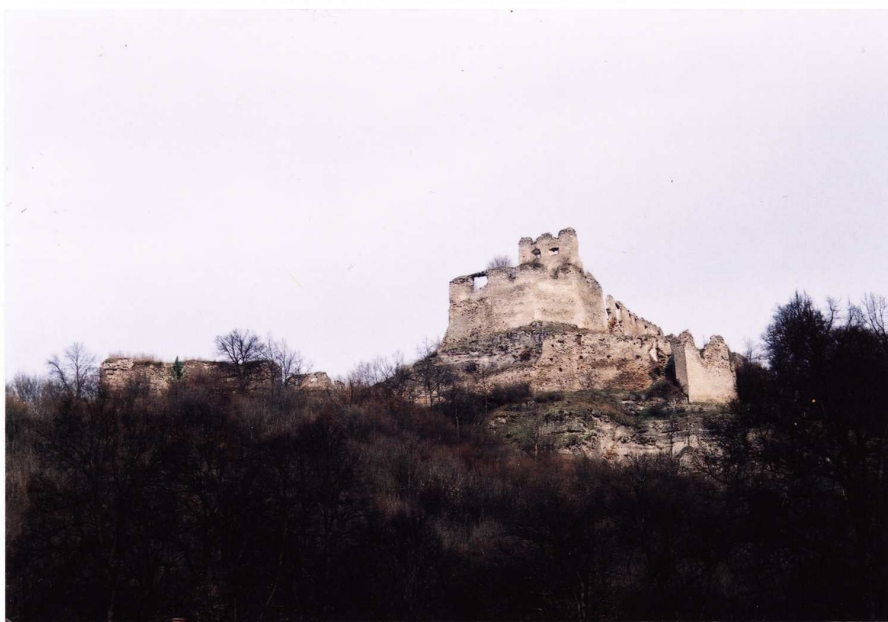
Pohľad na hrad od juhovýchodu
